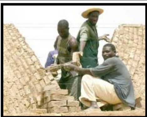
Kelbo, Maçons CSB. Photo: Wyss, 2005
