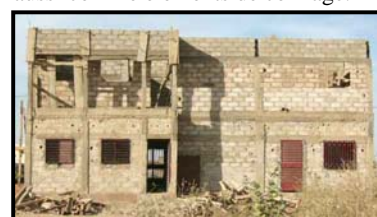
Ouvrage « définitif », Ouagadougou. Wyss, '05
