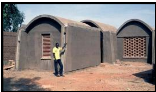
Gando, Logements en BTC, Toiture voûte coffrée, Enduit bitume-sable
