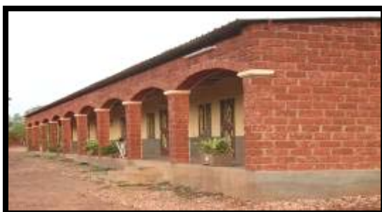
Bobo-Dioulasso, Centre Mater Christi, arcs surbaissés BLT
