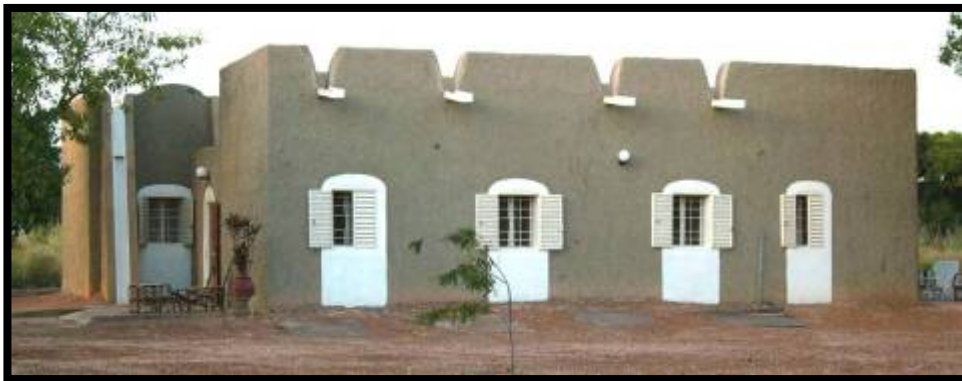
Saaba, Habitat de standing élevé, Toitures en voûtes et coupoles CSB, Enduit en terre et sable-bitume. Photo : Wyss, 2005
