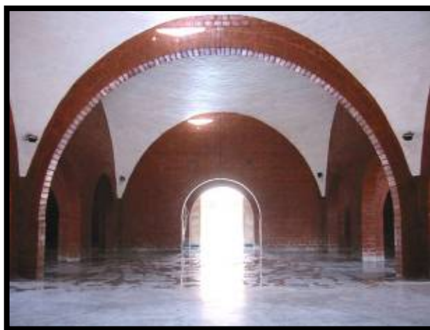
SIAO. Espace Art et Métiers, CSB en BTC, PAB. Photo: L. Séchaud '02
