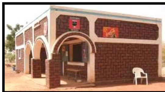
Toma, Bar en BLT-mixte, joints goudronnés
