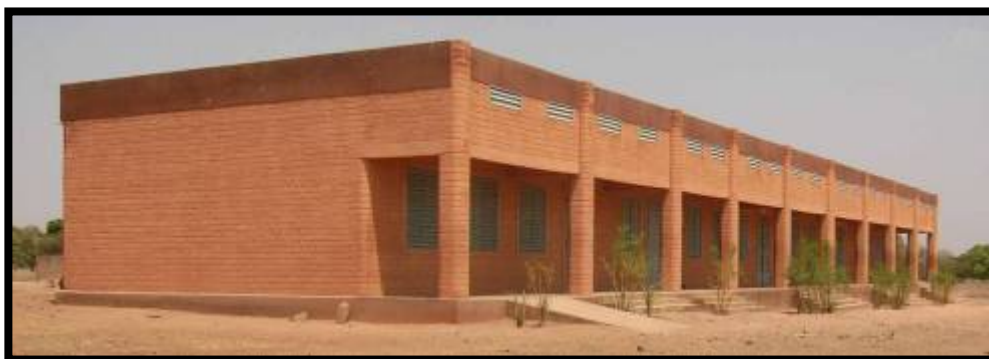
Béré, Collège d'Enseignement Général (CEG), Murs en BTC apparent, LOCOMAT, 2001. Photo : Wyss, 2005
