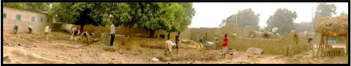
Boromo, Panorama, Chantier à 3 VN à différents stades 1 . Photo: David Sillou, 2005
