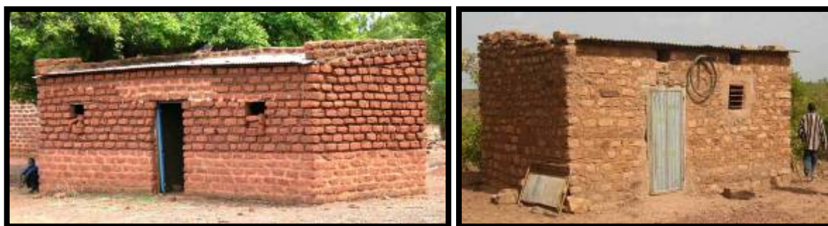
Dano, Céliatorium, BLT mis en œuvre à l'aide d'un mortier en terre
