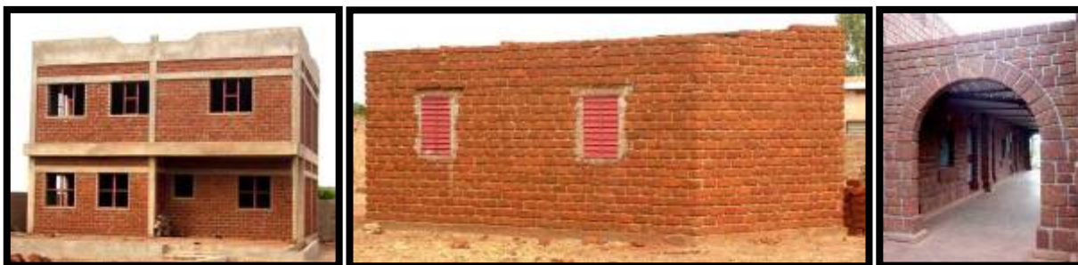
Diébougou : Habitat en étage de standing élevé, système mixte - Céliatorium en BLT porteur - Entrée monastère en arc. Photo : Wyss, 2005
