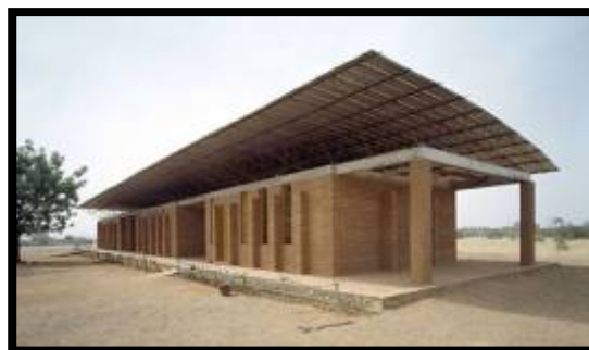
Ecole en BTC, Toiture bioclimatique www.fuergando.de
